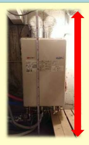
地下の高さが 140cm 有れば施工可能
