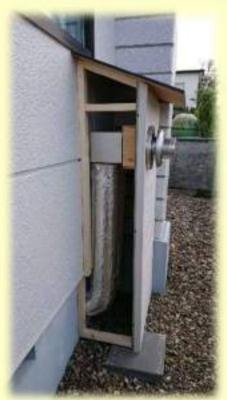
落雪・積雪が気になる方には 給排気トップを補強します。
