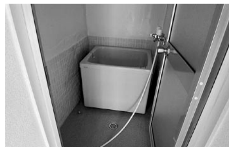
浴槽の狭い、タイル張りの浴室
