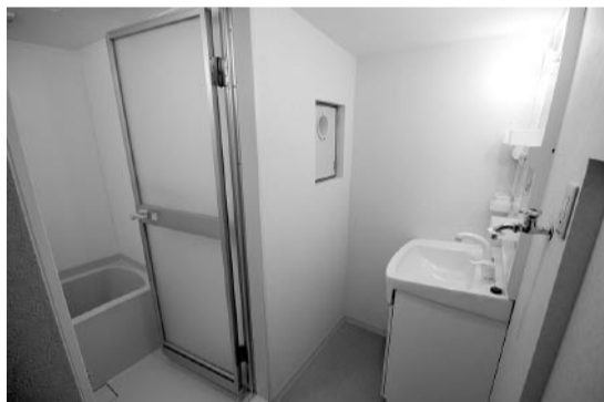
使いやすい掃除もしやすいユニットバスを設置
